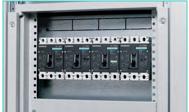
Abgangskombination mit Leistungsschaltern SENTRON 3VL
