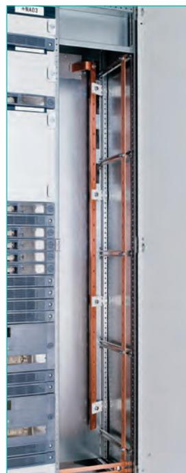
Die vertikalen PE- und N-Schienen befinden sich auf der rechten Seite des Kabelfachs.
