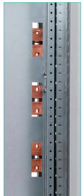
Die Anschlusspunkte der Hauptsammelschiene sind von der Vorderseite der Schaltanlage aus zugänglich.
